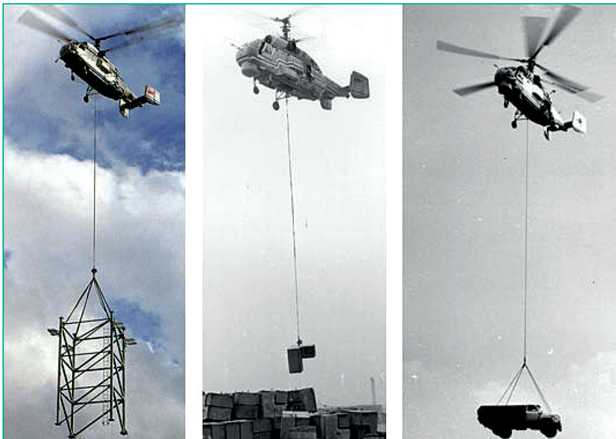
Рисунок 5. Вертолет Ка-32 при выполнении монтажных и погрузочно-разгрузочных работ и транспортировке груза на внешней подвеске
